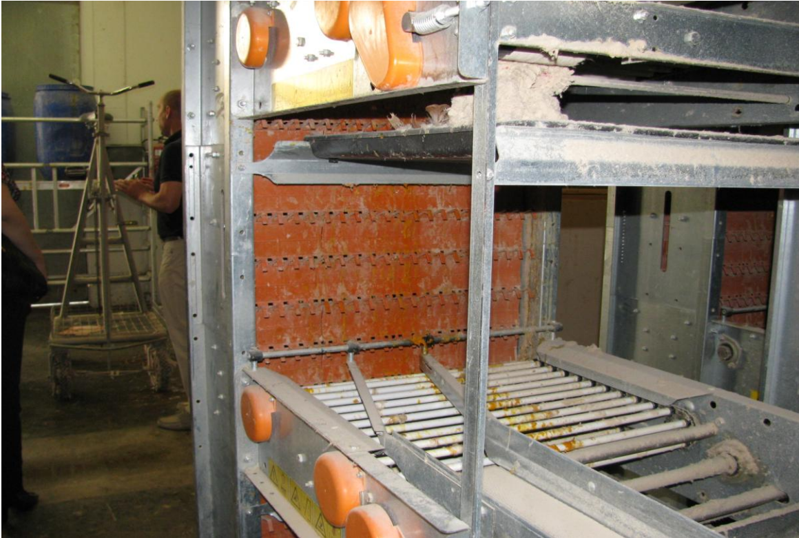
Lifturi montate la capatul bateriilor pentru colectarea oulor
